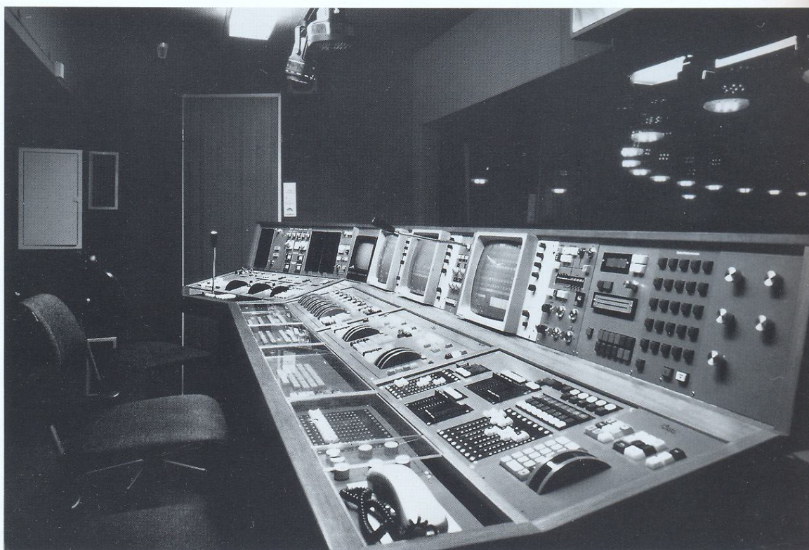
403. “Диммерная” комната для большой системы с рэками для диммерных модулей на 5000 и 10000 Вт. Лампы накаливания (вверху) использовались в качестве базовой нагрузки в электрических цепях флюоресцентных ламп. Ок. 1980
