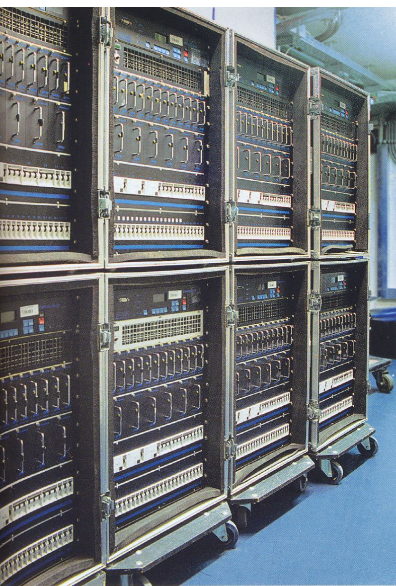
372. Рэки для мобильных цифровых диммеров
