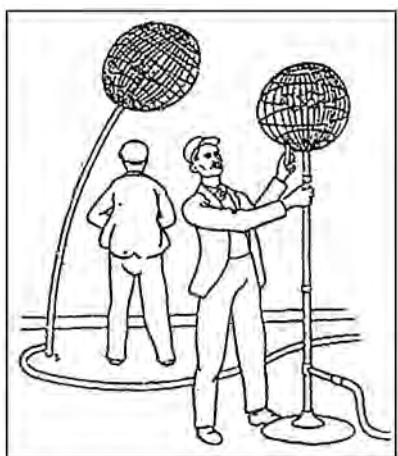
Переносной прибор газового освещения
